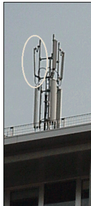
Pannello / Sistema radiante di una Stazione Radio Base per telefonia cellulare
