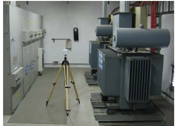
Misura del campo magnetico in prossimità di trasformatori.
